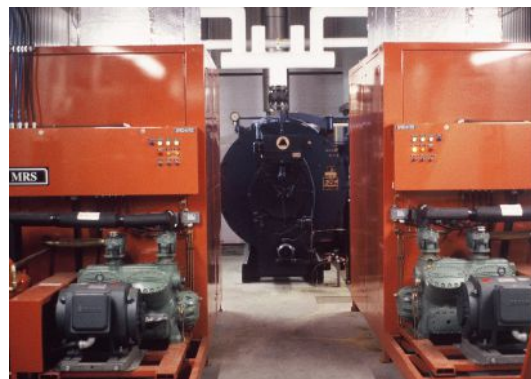
HAUT : Système Nyle multi-pompes ( 2 à 3 pompes ) qui permet le délestage progressif de la capacité des pompes au fur et à mesure de l'avance du séchage pour diminuer la consommation électrique et augmenter la longévité des pompes en évitant le cyclage. DROITE : Illustration de la configuration pompe à chaleur hybride avec chaudière à la vapeur
