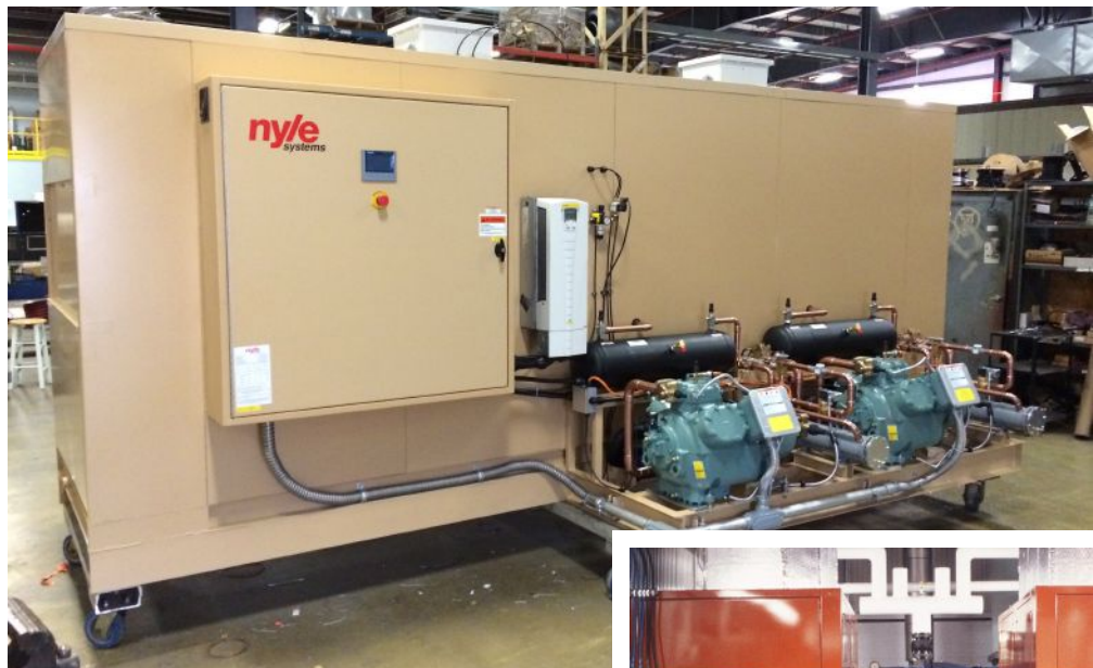
HAUT : Système Nyle multi-pompes ( 2 à 3 pompes ) qui permet le délestage progressif de la capacité des pompes au fur et à mesure de l'avance du séchage pour diminuer la consommation électrique et augmenter la longévité des pompes en évitant le cyclage. DROITE : Illustration de la configuration pompe à chaleur hybride avec chaudière à la vapeur
