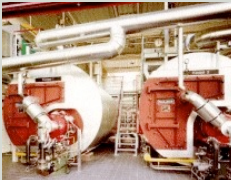
Brûleur hybride à poudre installé sur chaudière
